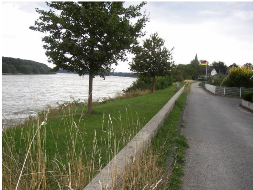
Bild 7: Hochwasserschutzmauer im Bereich Rhein-km 663,70 – 664,1
